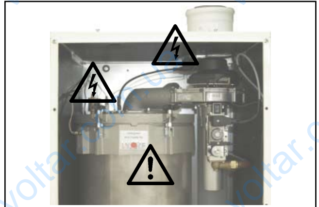
Рис.: Трансформатор поджига, электрод поджига, теплообменник. Опасность поражения электрическим током, опасность ожога из-за нагретых деталей.
