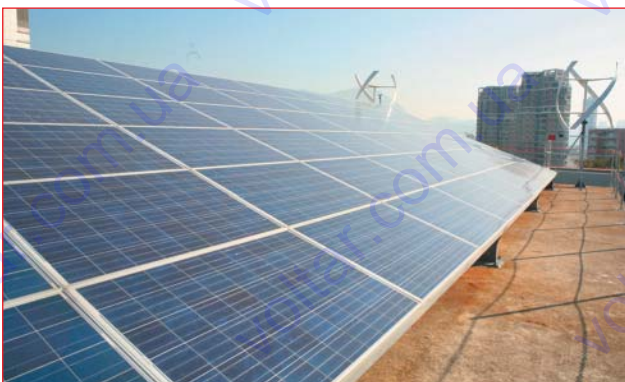
Китай, Гонконг, районный госпиталь
