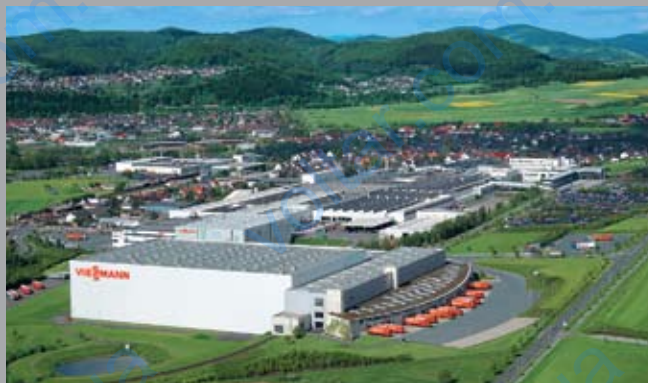
Завод Viessmann в г. Аллендорф / Германия
