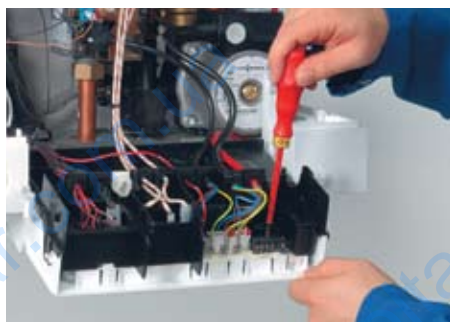
3. Подключение электрических присоединений
