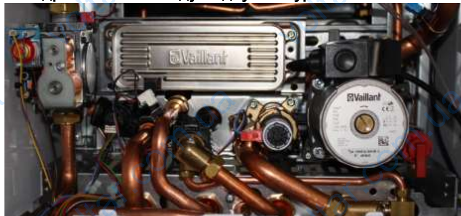
Гидравлический модуль двухконтурного котла VUW
