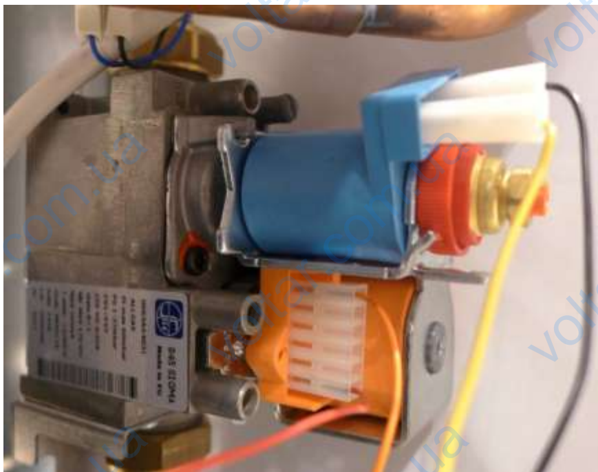
Газовый клапан SIT с пневматическим регулированием смешивания газ – воздух
