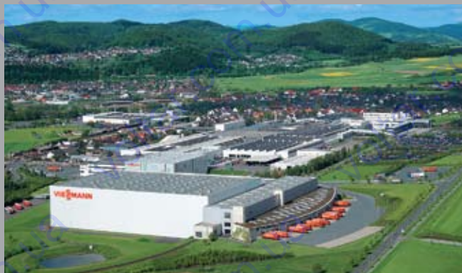
Завод Viessmann в г. Аллендорф / Германия
