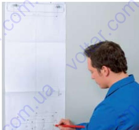
1. Предварительная разметка с помощью монтажного шаблона
