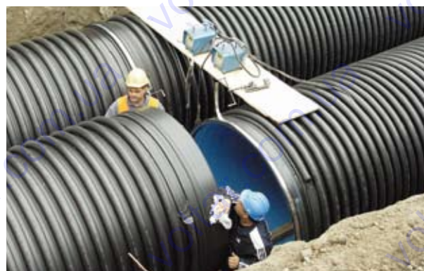
Зварювання труб великого діаметра у вузькій траншеї
