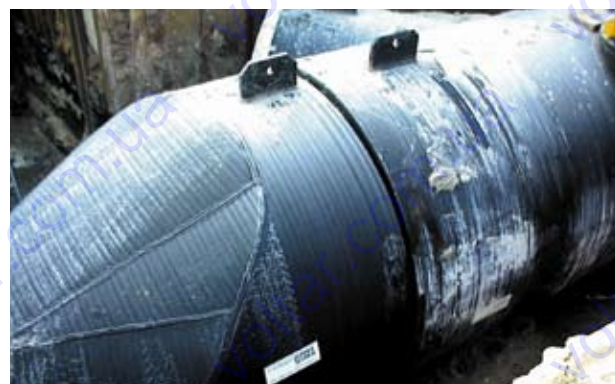
Перехід з DN/ID 2400мм на DN/ID 1200 мм
