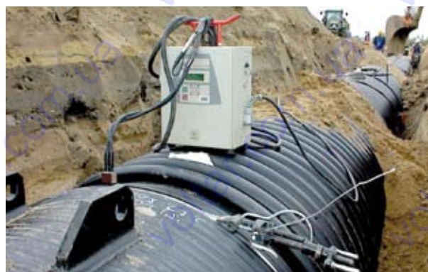
Процедура електроплавлення
