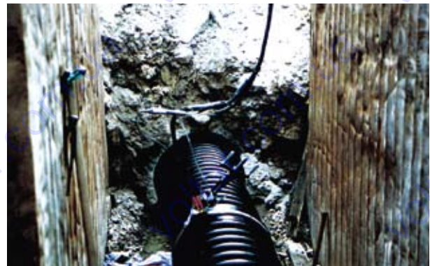
Релайнінг всередині бетонного трубопроводу
