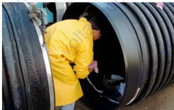
З'єднання труб з допомогою електроплавлення
