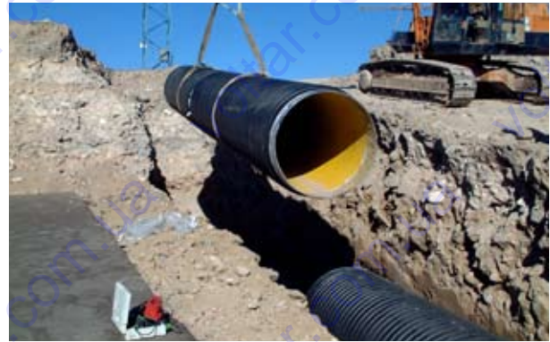
Монтаж попередньо зістикованих труб
