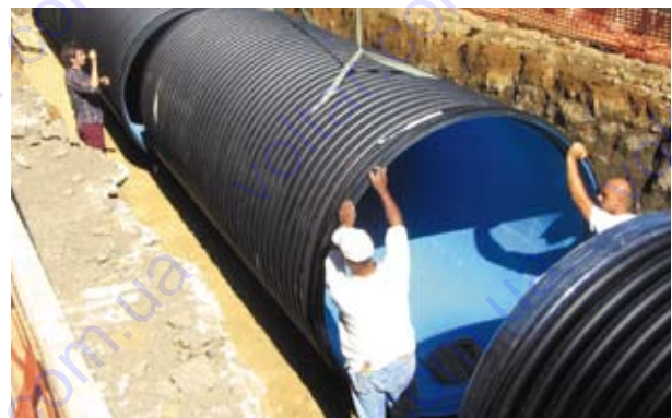
Монтаж трубопроводу DN/ID 2000 мм
