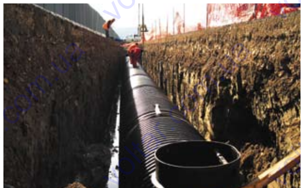
Процес прокладання труб
