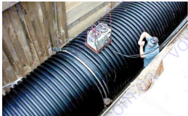
Виконання електрофузійного зварювання в траншеї
