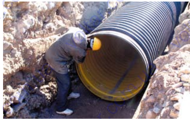
Монтаж труб Kraib у вузькій траншеї
