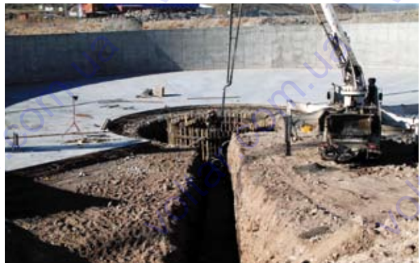
Монтаж ємностей зберігання води для басейну
