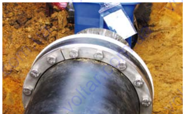
Фланцеве з'єднання
