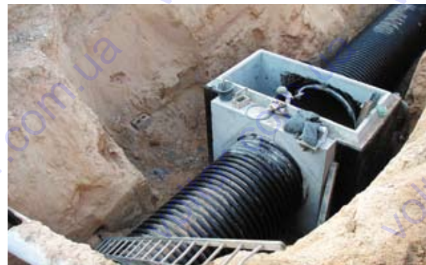
Монтаж трубопроводу з шахтами
