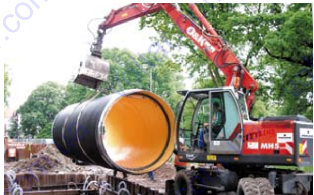
Установлення резервуару для дощової води
