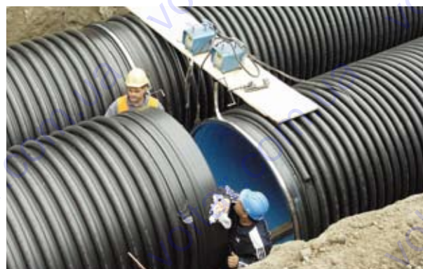
Зварювання труб великого діаметра у вузькій траншеї
