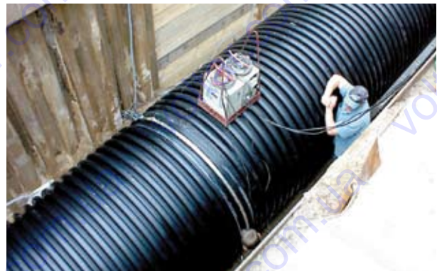
Виконання електрофузійного зварювання в траншеї
