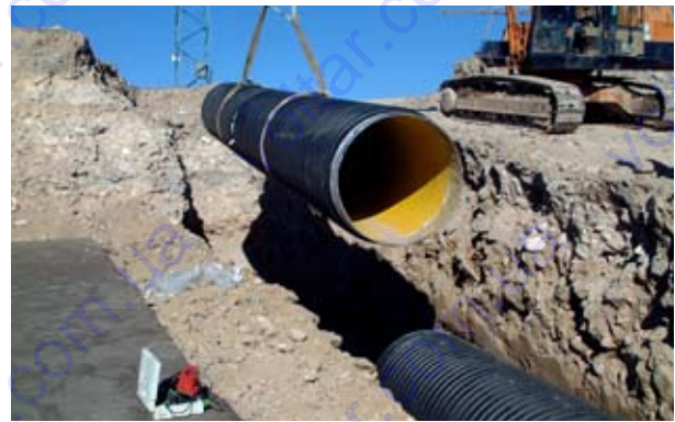
Монтаж попередньо зістикованих труб
