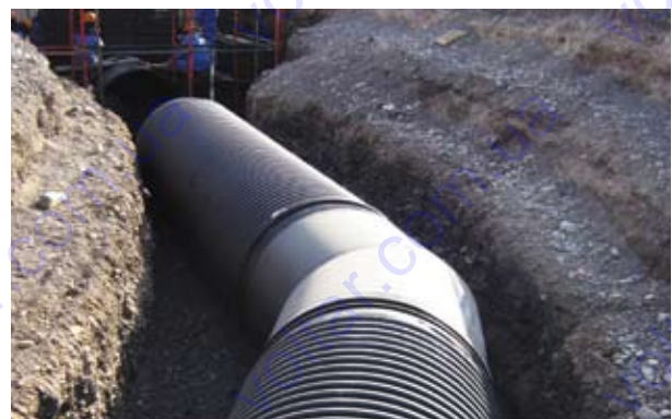
Монтаж трубопроводу DN/ID 2000 мм з фітингами
