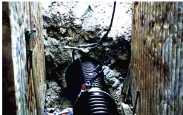
Релайнінг всередині бетонного трубопроводу
