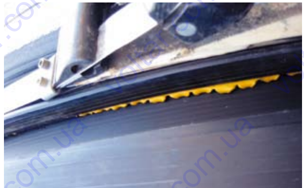
Електроплавлення
