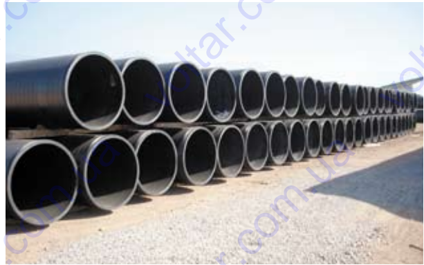
Приклад типового зберігання труб
