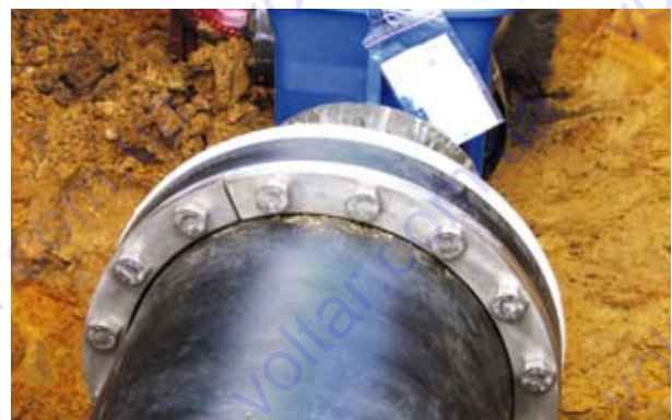
Фланцеве з'єднання
