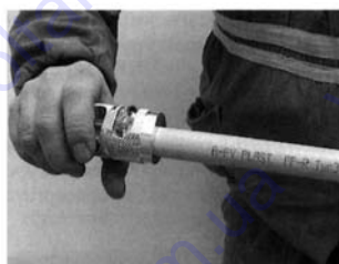
рис. 36: У труб STABI нужно удалить, с помощью трубореза, верхние пластовый и алюминиевый слои. Полученная таким образом пластиковая труба будет иметь гладкую поверхность и соответствующие размеры, отвечающие требованиям для диффузионного сваривания.
