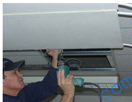
Монтаж потолочных охлаждающих панелей
