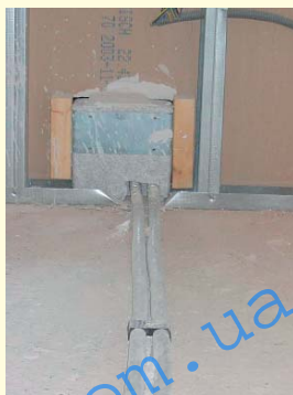
Пример: подключение от встраиваемых распределителей ГЕРЦ
