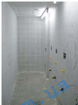
Пример: монтаж в стеновых перегородках
