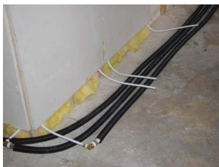
Подключение стеновых отопительных панелей
