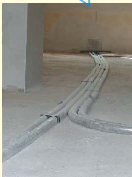
Пример: подключение от встраиваемых распределителей ГЕРЦ
