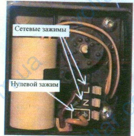
Рис. Подсоединение проводов к насосу Ц.О.
